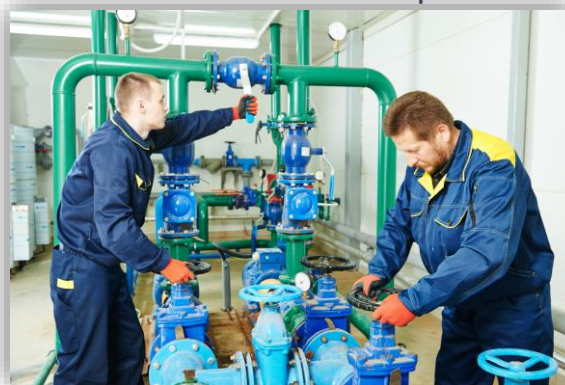
Devenir Monteur en Installations Thermiques
