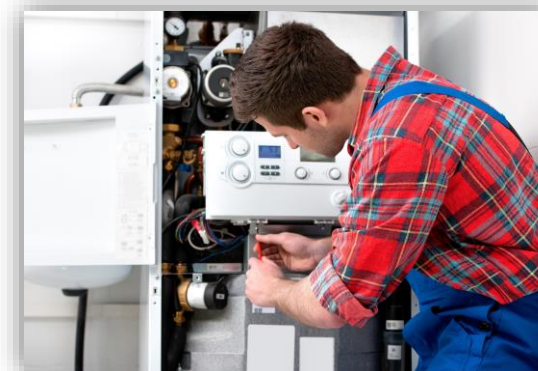
Devenir Agent de Maintenance en chaufferie
