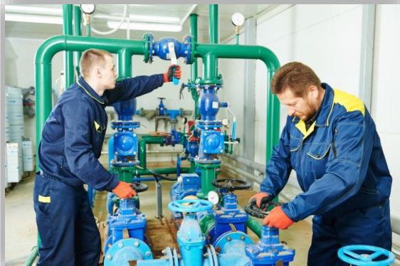
Devenir Monteur en Installations Thermiques
